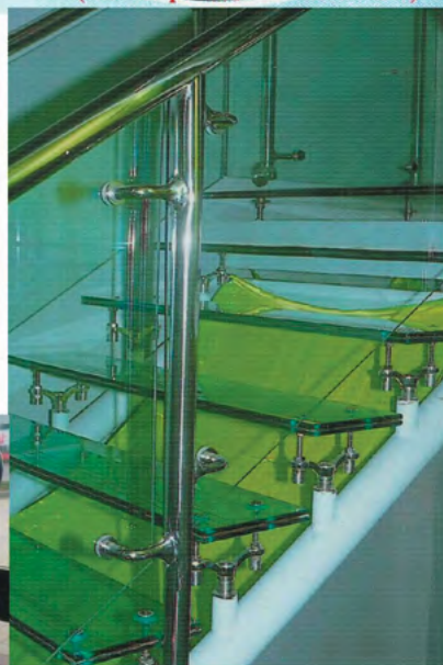
Пример углового соединения (Спайдер 200 двойной-стойка)
